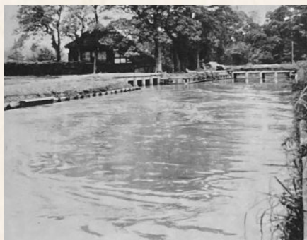
東西縁分水口（上尾市瓦葺地内） 昭和初期
