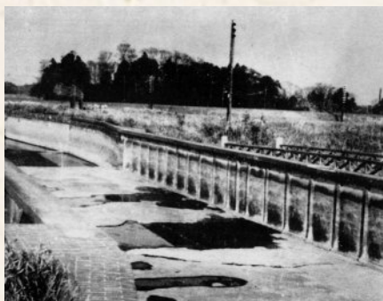
瓦葺掛樋井 明治40年代
