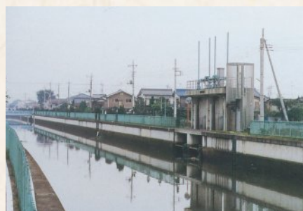
水路の改築による機能回復と 送水ロスの改善 （基幹線水路その1）
