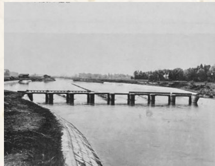
沈砂池（行田市大字荒木地内） 昭和30年代
