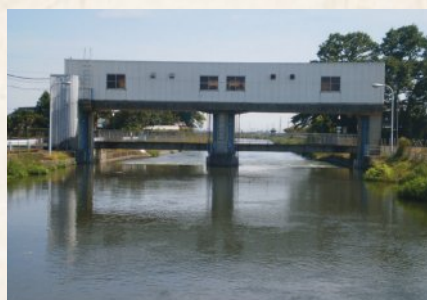
水位調節堰の建設による 水位維持用水の節減 （行田第二調節堰）
