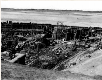
元込工事中 昭和初期
